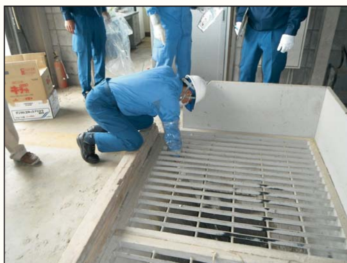
【荷受口モニタリングの様子】
