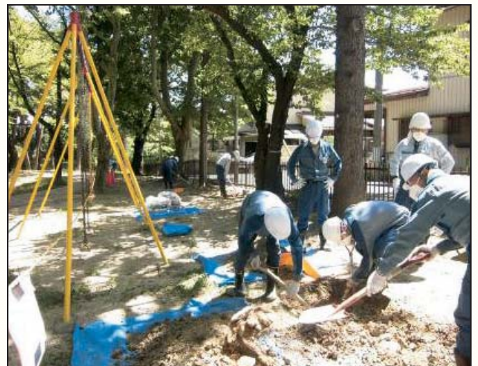
【簡易除染の様子】
