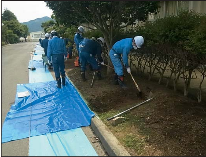
【簡易除染の様子】
