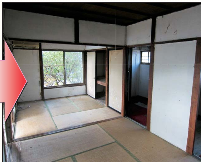
片付け後の様子【平成25年12月4日】
