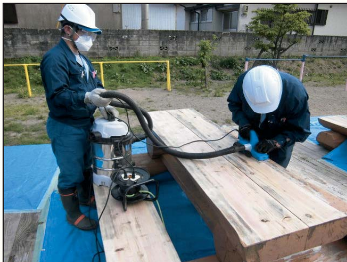
【簡易除染の様子】
