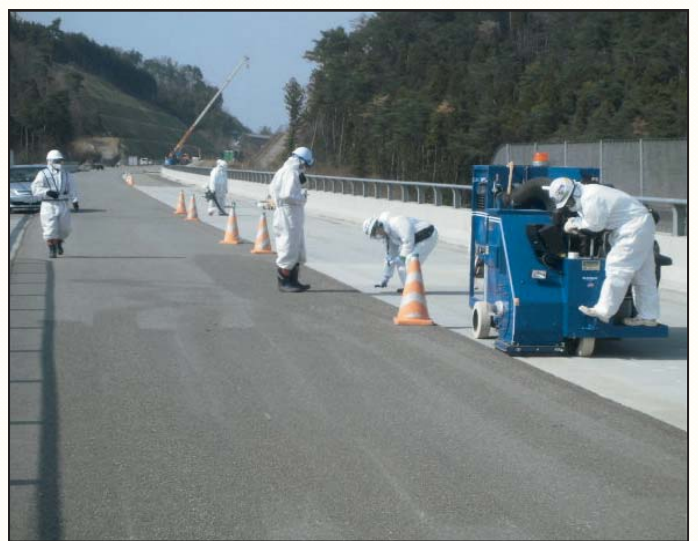
【橋梁部ブラスト作業の様子】
