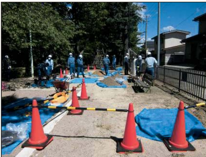
【簡易除染の様子】
